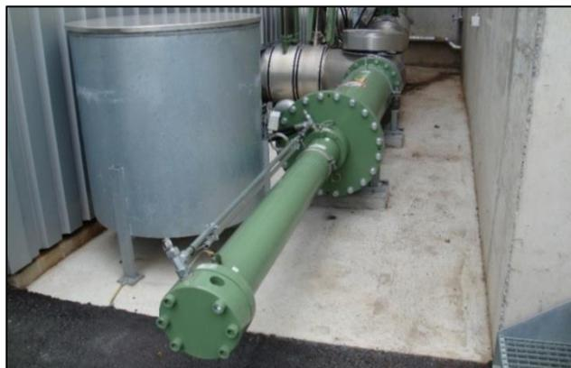
Figura 26 - Sistema di estrazione del digestato
