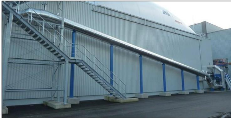
Figura 24 - Condotta di alimentazione del digestore
